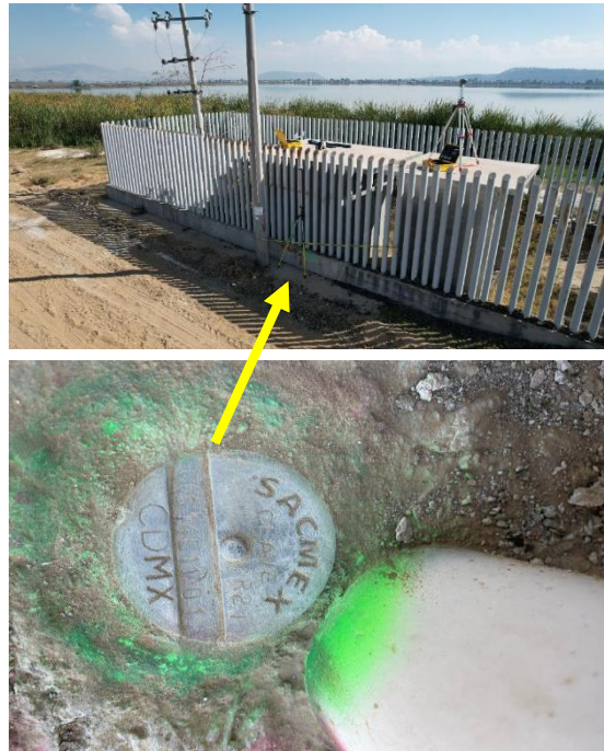
Figura 24. Referencia topográfica a través de placa metálica C(S14E11)01 del SACMEX
