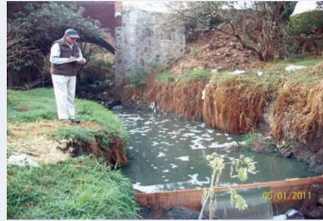
Monitoreo del cauce del Río Amecameca, para determinar su aforo y calidad en el estiaje, para así poder diseñar una planta de tratamiento municipal, y para observar su comportamiento durante lluvias fuertes, para el diseño de una laguna de infiltración de aguas pluviales.
